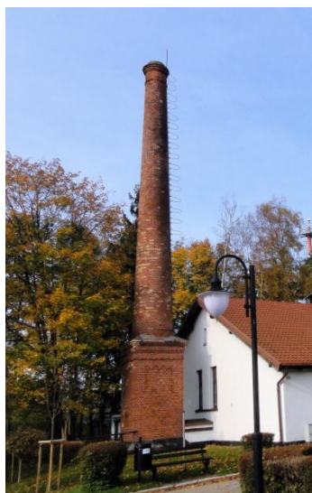
KOMIN MASZYNOWNI w zespole latarni morskiej ROZEWIE I
