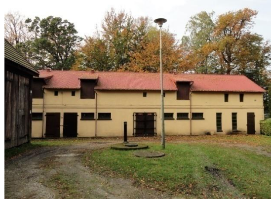
BUDYNEK INWENTARSKI w zespole latarni morskiej ROZEWIE II
