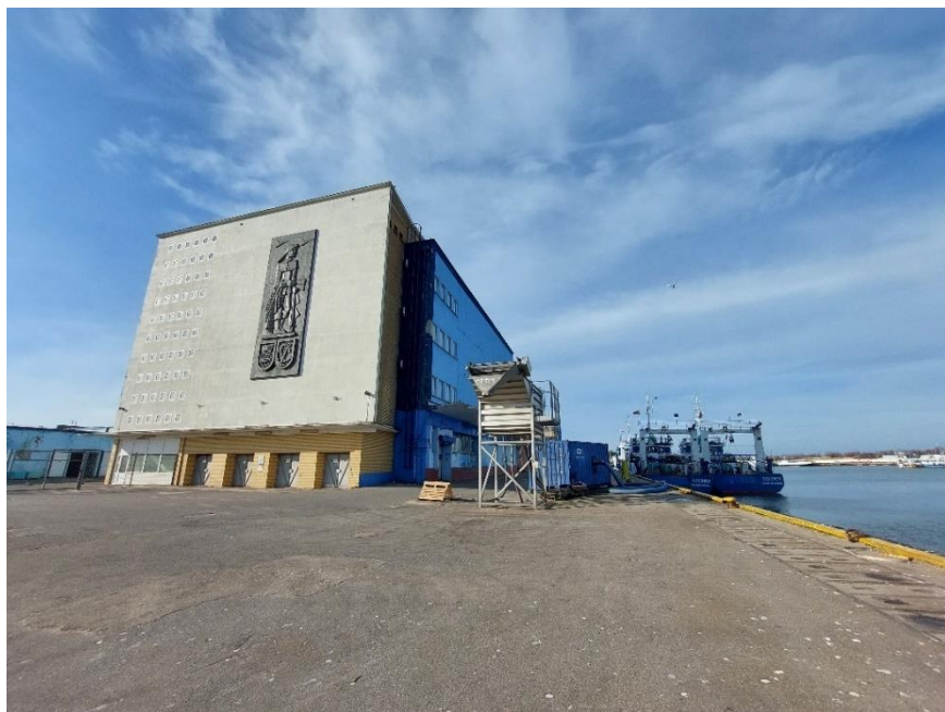
Fot. 4. Fragment portu morskiego we Władysławowie – infrastruktura wymagająca modernizacji (autor: A. Fijałkowska 2022 r.).
