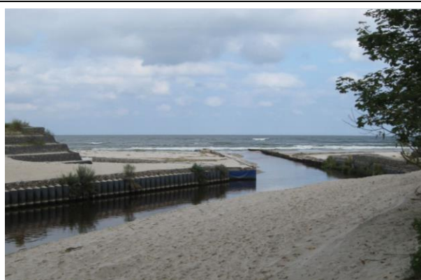
Fot. 2. Ujście Czarnej Wody do Morza Bałtyckiego (wrzesień 2017 r.)
