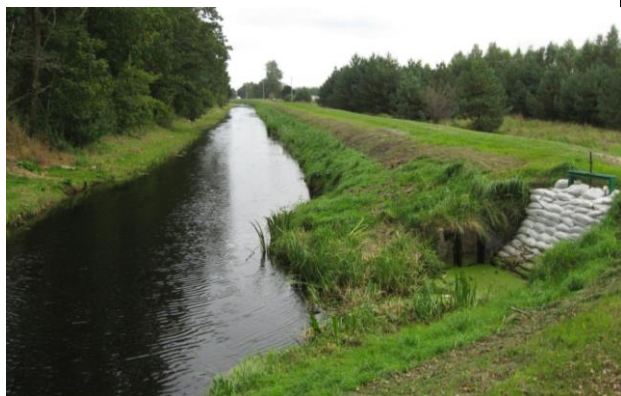
Fot. 1. Czarna Woda z mostu na wschód od Karwii (wrzesień 2017 r.)
