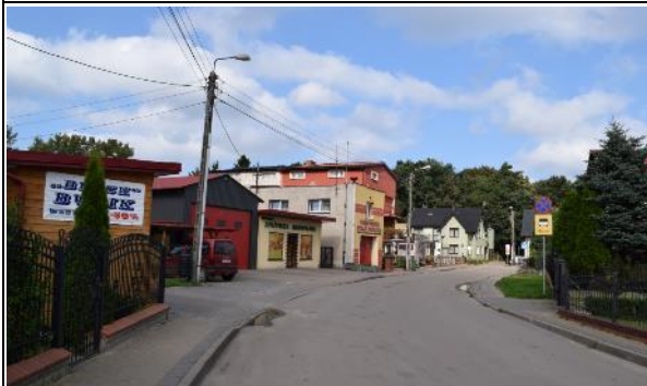
Zdj. 145. Zabudowa przy ul. 12 Marca w rejonie remizy strażackiej- widok w kierunku północnym
