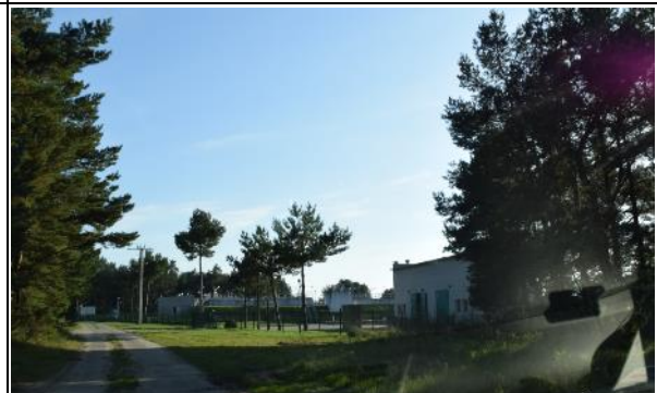
Zdj. 235. Teren oczyszczalni ścieków w dolinie Czarnej Wody- widok z drogi dojazdowej
