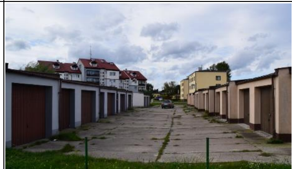
Zdj. 35. Zespół garaży przy ul. Władysława IV, widoczne są również w oddali domy wielorodzinne przy ul. Abrahama- widok z przejścia pieszego pomiędzy Urzędem Miejskim a ul. Władysława IV w kierunku północno- zachodnim
