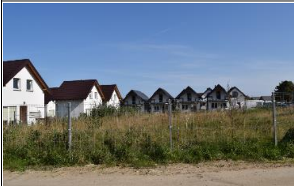
Zdj. 226. Zespół domków na wynajem w budowie przy ul. Kuracyjnej
