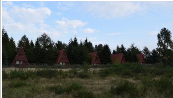
Zdj. 258. Ośrodek wypoczynkowy „Relaks” przy ul. Bielawskiej- widok z ul. Kasztanowej
