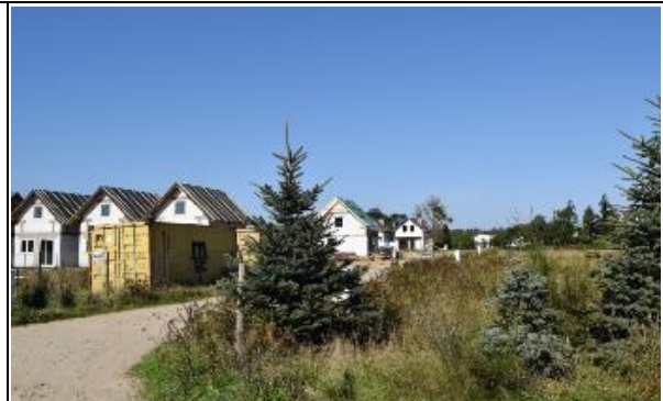
Zdj. 233. Tereny pomiędzy ul. Pucką a ul. Zbożową to rejon, gdzie powstają zespoły domków kempingowych na wynajem- widok z ul. Zbożowej
