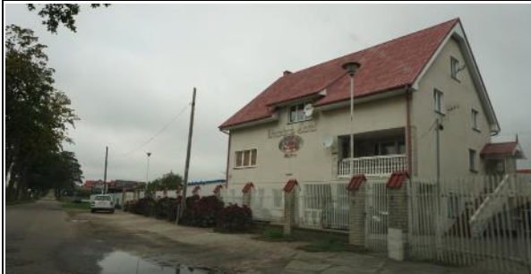
Zdj. 53. Zabudowa przy ul. Droga Chłapowska na zachód od przejazdu kolejowego- widok w kierunku północnym
