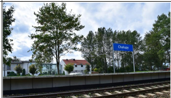
Zdj. 337. Przystanek kolejowy w części zachodniej Chałup- widok od północy
