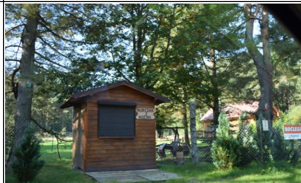
Zdj. 341. Tymczasowy obiekt handlowy przy ul. Garnizonowej, zaś w głębi widoczny jeden z domów letniskowych
