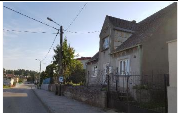
Zdj. 303. Zabudowa wzdłuż ul. Puckiej- widok w kierunku południowym
