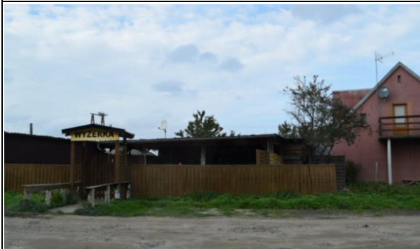
Zdj. 183. Zabudowa przy ul. Krokowskiej- widok w kierunku północnym
