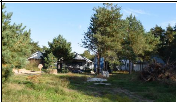
Zdj. 293. Domki kempingowe na wynajem przy ul. Myśliwskiej w Ostrowskich Pustkach - zespół w trakcie budowy
