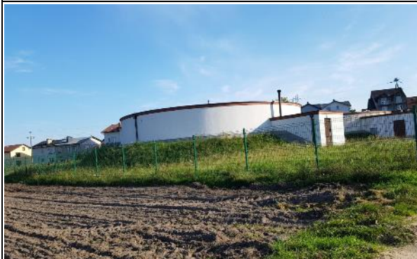
Zdj. 256. Zbiorniki wyrównawcze na terenie stacji wodociągowej przy ul. Do Źródłka
