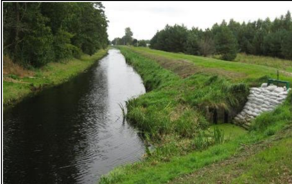
Zdj. 428. Czarna Wda w rejonie drogi do Ostrowa Pustek- widok w kierunku południowo wschodnim z wału przeciwpowodziowego
