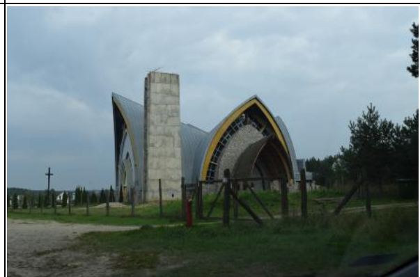
Zdj. 243. Kościół przy ul. Sosnowej- na zachodnim skraju wsi- widok od zachodu
