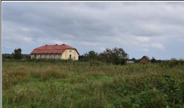
Zdj. 159. Pensjonat przy ul. Ekologicznej- widok z ul. ks. B. Lewińskiego
