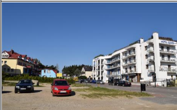
Zdj. 201. Zabudowa – hotele, pensjonaty, obiekty usługowo- handlowe przy ul. Droga Rybacka- widok z okolicy placu zabaw
