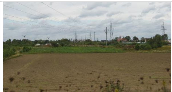
Zdj. 48. Widok na część osiedla Żwirowa na północ od ul. Skandynawskiej - tereny rolnicze w sąsiedztwie stacji transformatorowej GPZ-głównego punktu zasilania w mieście - widok z ul. Skandynawskiej
