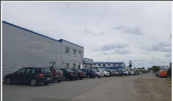
Zdj. 50. Zakłady przetwórstwa rybnego przy ul. Skandynawskiej- widok z ulicy w kierunku ul. Gdańskiej
