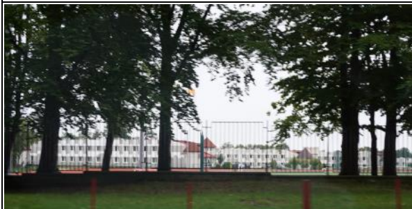
Zdj. 88. Centralny Ośrodek Sportu w Cetniewie- widok od Al. Żeromskiego
