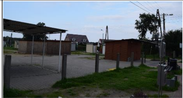
Zdj. 239. Obiekty handlowe tymczasowe w centrum wsi przy ul. Plażowej- widok z ul. Sosnowej
