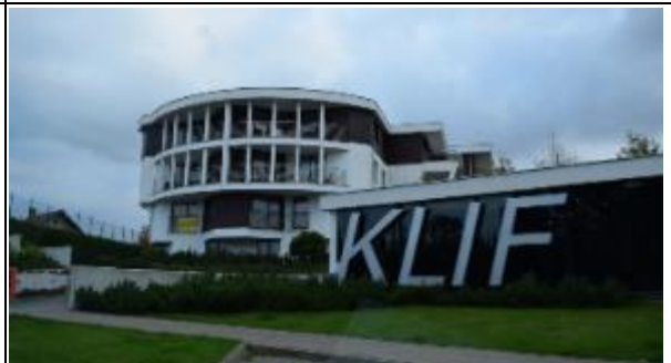
Zdj. 108. Apartamentowiec Klif przy al. Żeromskiego na wjeździe do Chłapowa od strony Rozewia- widok z al. Żeromskiego
