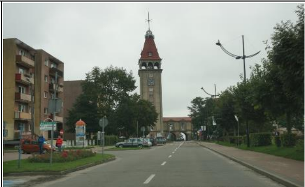
Zdj. 26. Wschodni fragment ul. Hallera z widoczną wysoką wieżą Domu Rybaka (siedziba Urzędu Miejskiego); z lewej strony widoczna jest zabudowa wielorodzinnna- "bloki"- przy ul. Rybackiej
