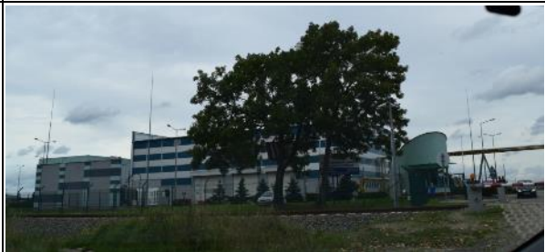
Zdj. 39. Teren Elektrociepłowni- widok od strony wjazdu z ul. Starowiejskiej
