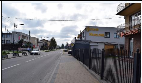
Zdj. 146. Zabudowa przy ul. M. Kopernika w części północnej miejscowości- widok na rejon skrzyżowania z ul. 12 Marca
