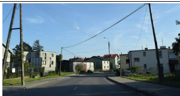
Fot. 55. Przykłady raczej podmiejskiej niż wiejskiej zabudowy mieszkalnej we wsi Tupadły. Ulica Pucka (wrzesień 2017r.)
