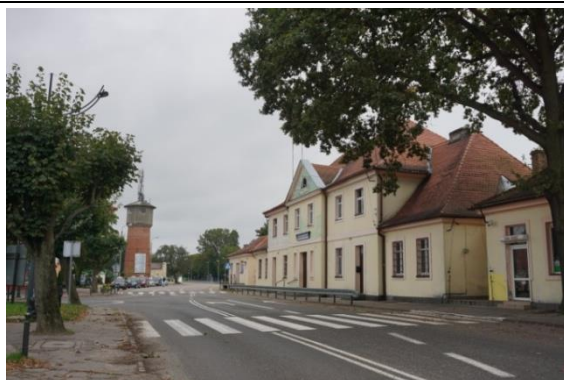
Fot. 53. Zespół dworca z kolejową wieżą ciśnień (wrzesień 2017r.)
