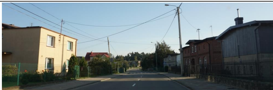
Fot. 22. Ulica Pucka w miejscowości Tupadły. Po prawej stronie: zachowana zabytkowa zabudowa (wrzesień 2017 r.)
