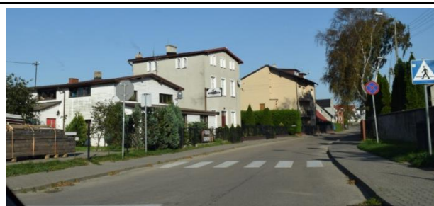
Fot. 65. Zabudowa ul. Plażowej w centrum wsi Ostrowo. Widok ze skrzyżowania z ul. Plażową w kierunku wschodnim (wrzesień 2017r.)
