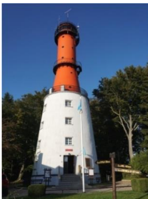
Zdj. 127. Latarnia Morska Rozewie I, ul. L. Wzorka
