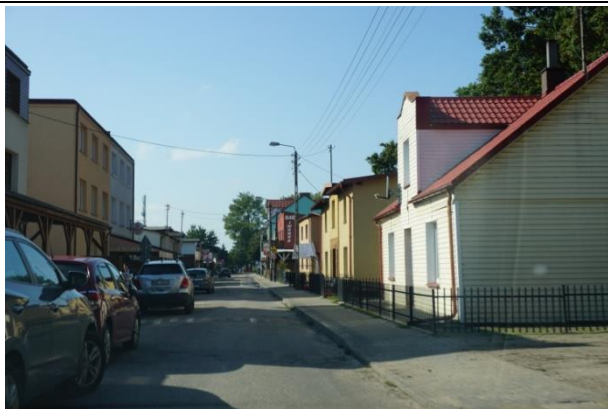
Zdj. 15. Zabudowa ul. Wojska Polskiego; od strony zachodniej od skrzyżowania z ul. Kopernika
