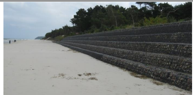
Zdj. 9. Plaża w okolicy ujścia Czarnej Wody do Bałtyku z gabionowym umocnieniem brzegu. Widok w kierunku wschodnim na Jastrzębią Górę
