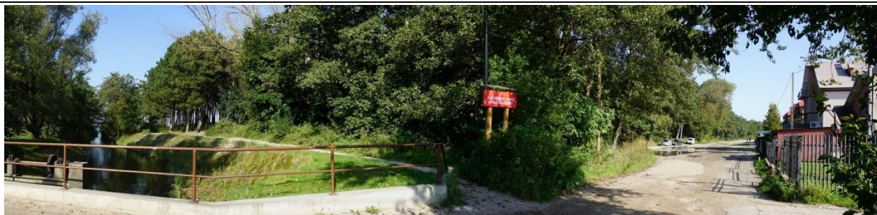
Zdj. 1. Widok na leśną część Pasa Nadmorskiego od strony Stacji Pomp Karwia
