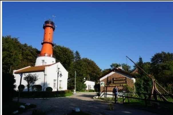
Zdj. 128. Zespół zabudowy latarni morskiej Rozewie I. Widok od strony południowo-zachodniej
