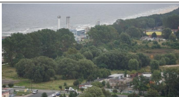
Zdj. 149. Budynek firmy Energobaltic widoczny od strony zachodniej, z wieży Domu Rybaka
