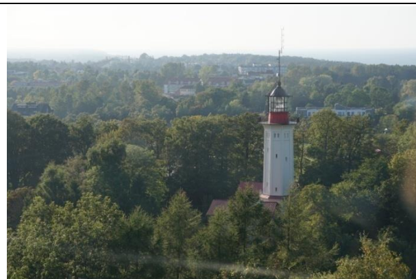
Zdj. 134. Latarnia Morska Rozewie II. Widok w kierunku zachodnim z latarni Rozewie I
