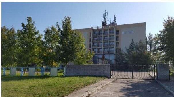
Zdj. 146. Hotel Hutnik, ul. Kuracyjna 3. Widok od strony północnej
