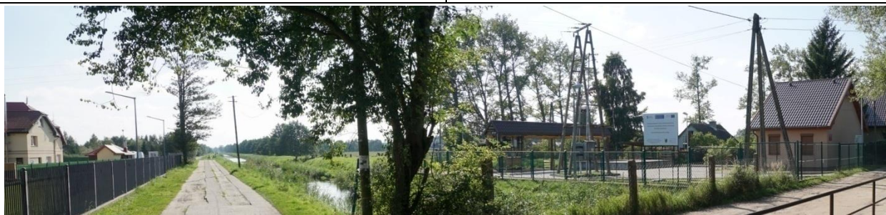
Zdj. 17. Zachodni kraniec Karwi. Widok w kierunku południowym. Po prawo: Stacja Pomp Karwia
