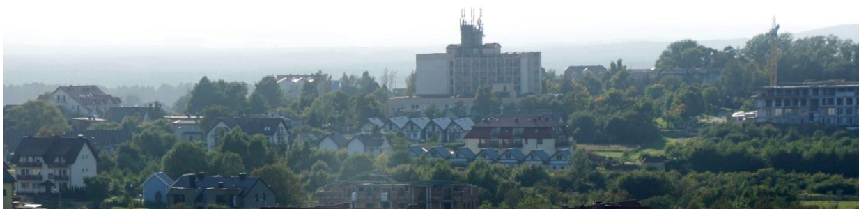
Zdj. 148. Widok z latarni morskiej w Rozewiu od strony północnej. Obiekt zwraca uwagę swą dużą kubaturą, wysokością (sześć kondygnacji) i kilkukondygnacyjną nadbudową na środku dachu z zainstalowanymi antenami GSM
