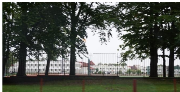
Zdj. 75. Centralny Ośrodek Sportu w Cetniewie - widok zespołu od ul. Żeromskiego
