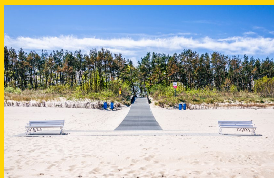
Budowa kładki na wejściu nr 21 A w Chałupach
