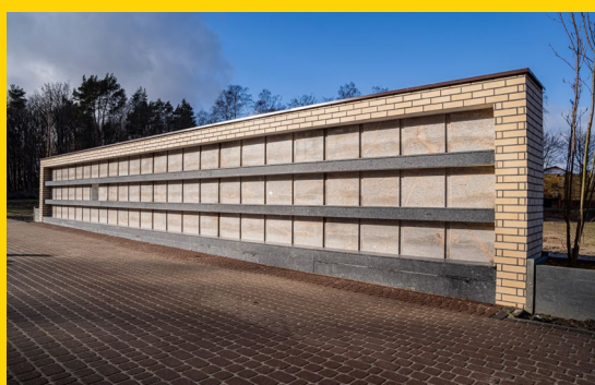
Budowa kolumbarium na Cmentarzu komunalnym we Władysławowie
