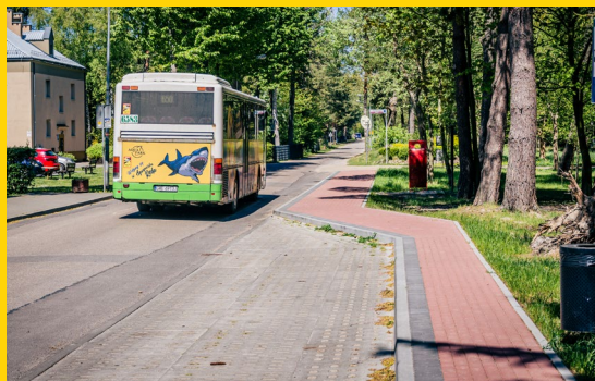
Sołectwo Rozewie - Budowa zatoczki autobusowej przy ul. Garnizonowej w Rozewiu
