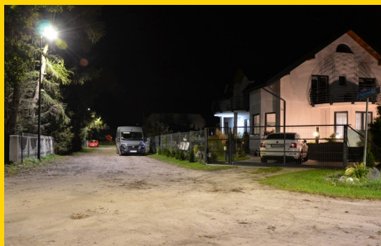
Sołectwo Karwia - Budowa oświetlenia ul. Płatynowej i ul. Srebrnej w Karwi
