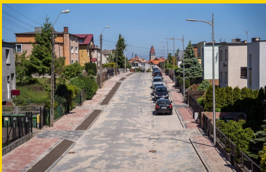
Przebudowa drogi gminnej ulicy F. Ceynowy we Władysławowie
