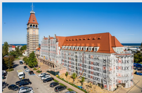
Termomodernizacja budynku Ratusza miejskiego we Władysławowie
