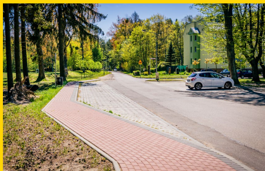
Budowa zatoczki autobusowej przy ul. Garnizonowej w Rozewiu
