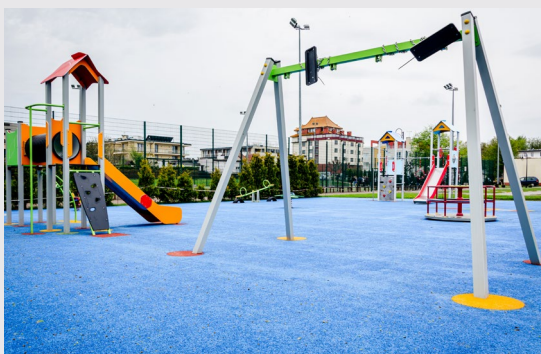
Wykonanie nawierzchni bezpiecznej placu zabaw przy ul. 1000-lecia P.P. we Władysławowie wraz z uwzględnieniem wymiany niektórych elementów na nowe
