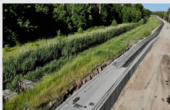
Kolejne odcinki ścieżki rowerowej
