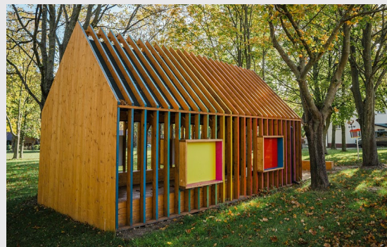
Przedszkole pod chmurką - Budowa tęczęwej altany do prowadzenia zajęć na świeżym powietrzu (Budżet Obywatelski obszar miejski)
