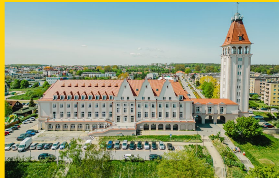
Kompleksowa modernizacja energetyczna budynków stanowiących własność Gminy Władysławowo - przebudowa OPS we Władysławowie
