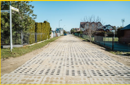
Modernizacja drogi gminnej ulicy Ludzi Morza w Chłapowie- poprzez ułożenie płyt jumb
