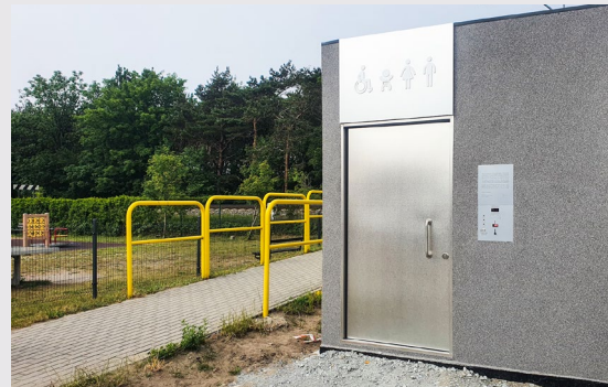
Budowa automatycznej toalety w miejscowości Chałupy (zadanie realizowane przez Centrum Kultury)
