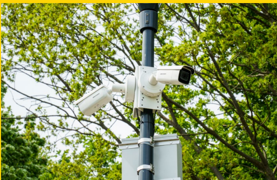
Budowa monitoringu miejskiego na terenie gminy Władysławowo
