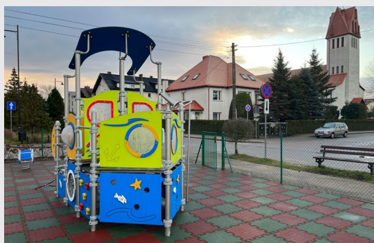
Wymiana urządzeń oraz nawierzchni na placu zabaw przy ul. Kolorowej w Karwi
