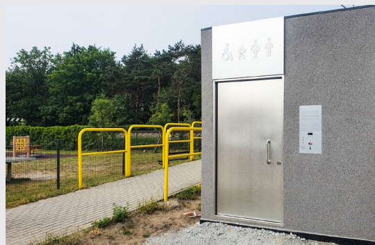
Budowa automatycznej toalety w miejscowości Chałupy (zadanie realizowane przez Centrum Kultury)
