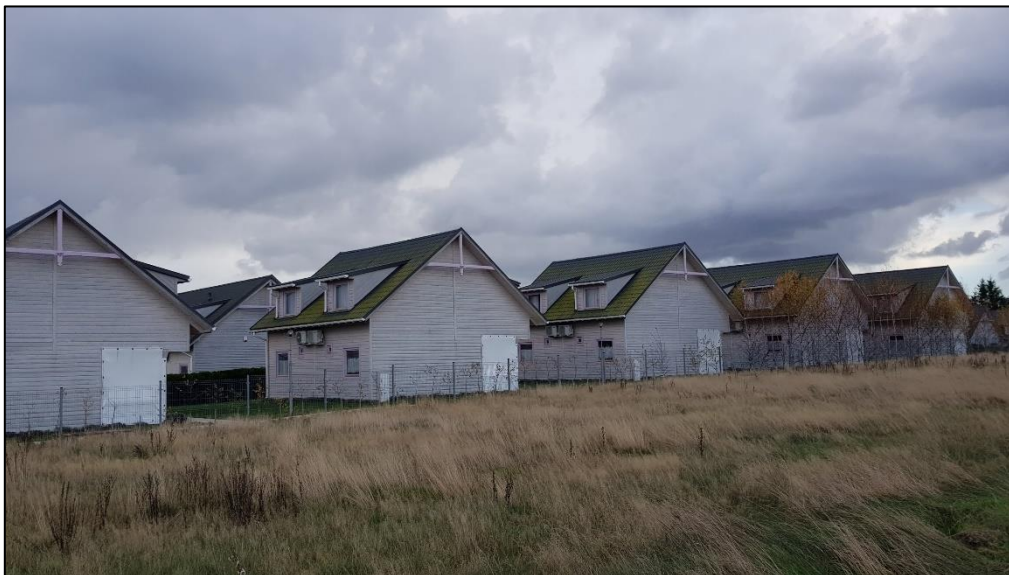
Fot. 4. Zabudowa turystyczno-rekreacyjna w środkowej części obszaru planu – wzdłuż ul. Do Źródłka.
