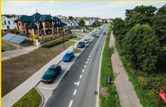
Budowa ul. Boh. Kaszubskich we Władysławowie na odcinku od ul. Geodetów do granicy z Gminą Puck
