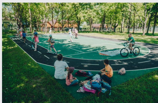
Wykonanie poliuretanowego miasteczka rowerowego przy Przedszkolu nr 1 we Władysławowie
