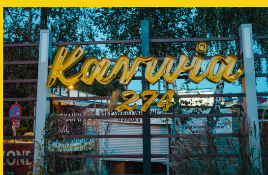
Budowa i montaż neonu „Karwia 1274”
