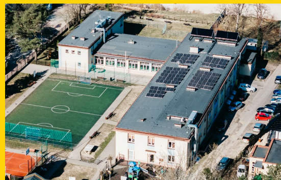
Montaż paneli fotowoltaicznych na budynkach Szkoły Podstawowej w Jastrzębiej Górze oraz Szkoły Podstawowej nr 2 i Zespołu Szkół nr 1 we Władysławowie w ramach programu „Słoneczne Szkoły Powiatu Puckiego”
