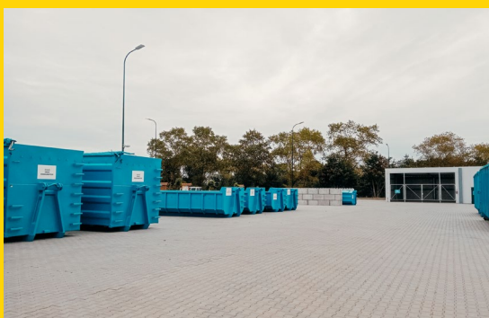
Budowa Funkcjonalnego Punktu Selektywnego Zbierania Odpadów Komunalnych
