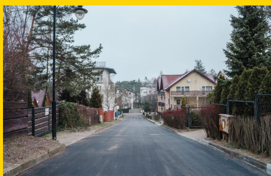
Remont nawierzchni bitumicznej ul. Zygmunta III w Jastrzębiej Górze
