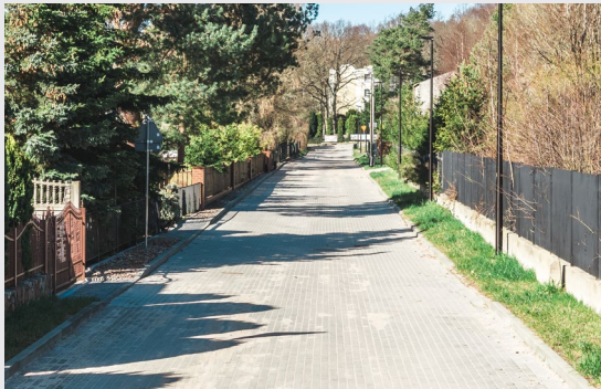
Budowa ul. Polnej w Jastrzębiej Górze wraz z kanalizacją deszczową w ul. Żarnowcowej celem odprowadzenia wód deszczowych
